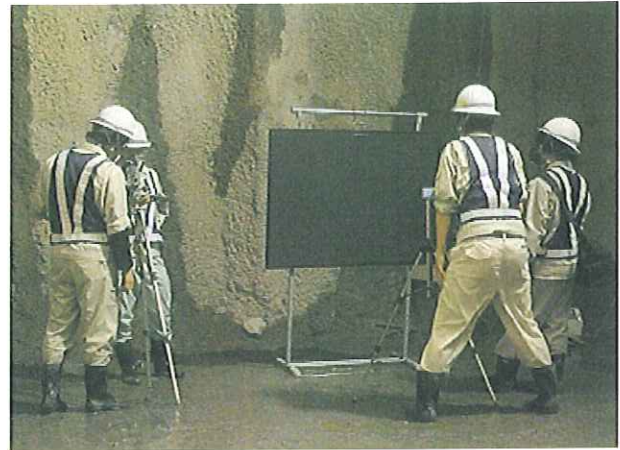
写真-3 フラッシュ撮影状況
