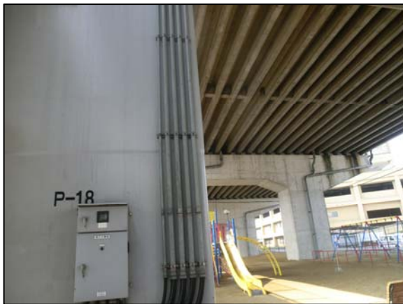
写真-9 高架下を公園として利用されている例
