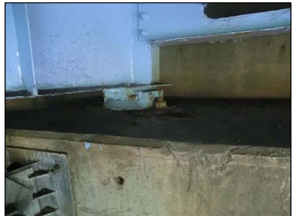
写真-7 橋座面の作業スペースが確保されている。
