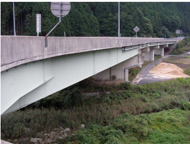
写真－13 水（湿気）による腐食防止及び維持管理の作業性確保を行っている橋梁例
