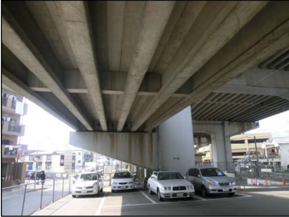
写真-8 高架下を駐車場として利用されている例
