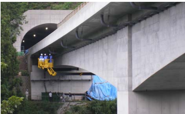
写真－1 橋梁点検車を利用した点検 （写真は、平成23年に行われた橋梁点検車操作説明会）
