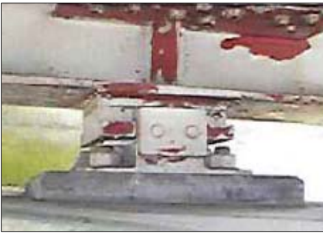
写真-3 中間支点部 (腐食は見られない)
