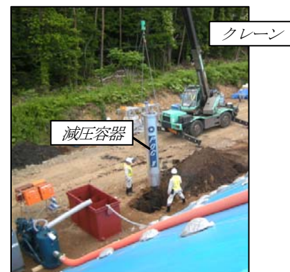
図-9 減圧室の地中埋設作業状況
