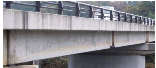
写真-2 リパッシブ工法を適用した橋梁
