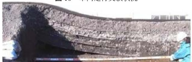
図11 複合剛性層による舗装の支持状況
