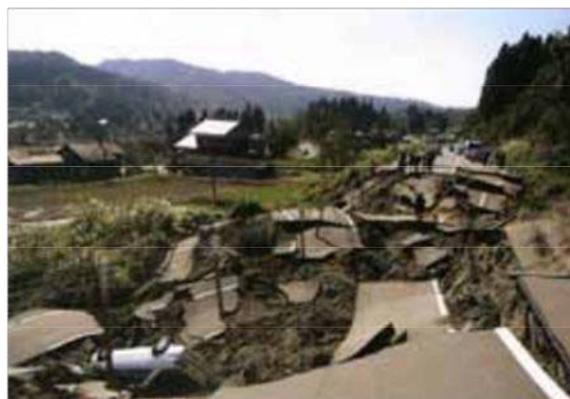
図1 2車線の崩壊の大規模なすべり破壊例<sup>3)</sup>
