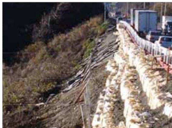
図2 のり面、路肩のすべり破壊に止まる被害例<sup>3)</sup>
