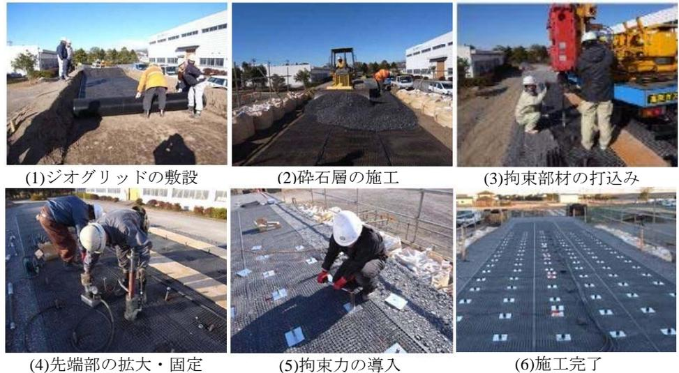
図 13 複合剛性層の施工状況
