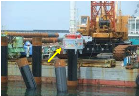
図-3 低減装置の打設実験状況 (直江津)
