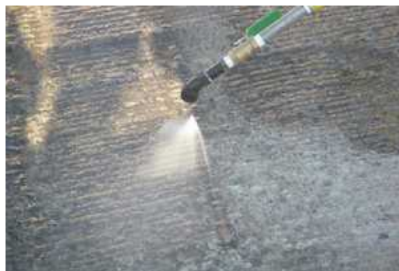
写真-4 エアレス式ノズルによる散布状況
