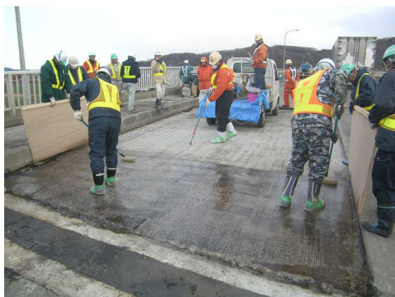
写真-3 浸透系エポキシ樹脂の散布・均し状況
