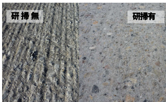
写真-2 切削後の既設床版における研掃有無の状況
