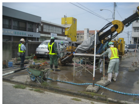
写真-4.1 施工状況写真
