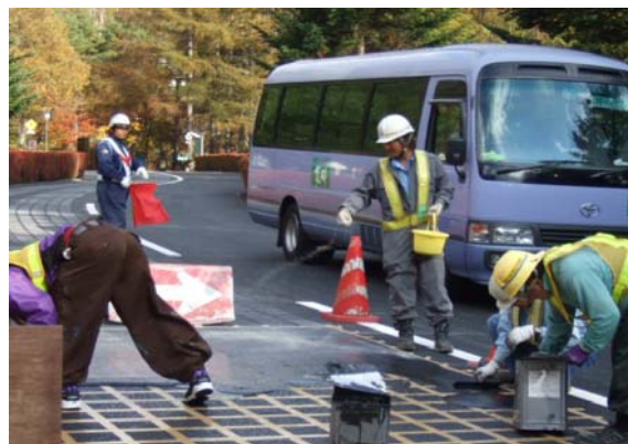
写真-7 珪砂散布状況
