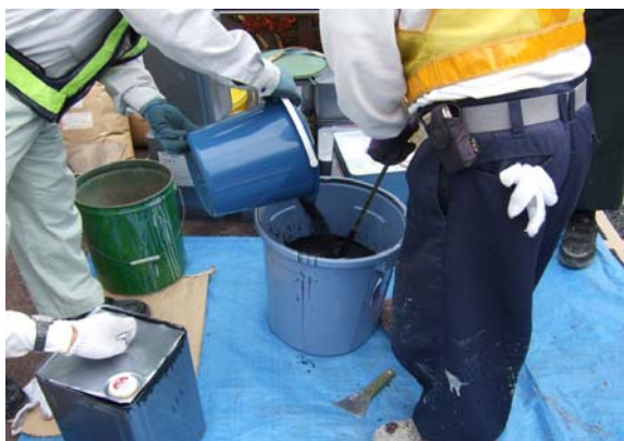
写真-5 充填材混合状況
