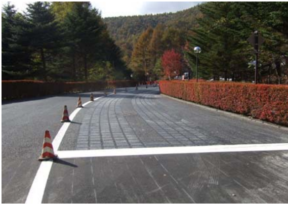
写真-9 完成後の路面状況
