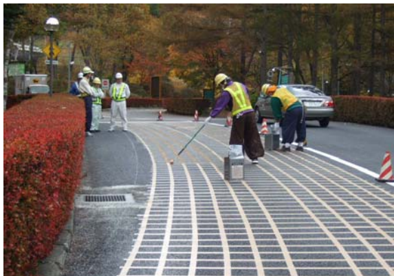
写真-4 プライマー塗布状況
