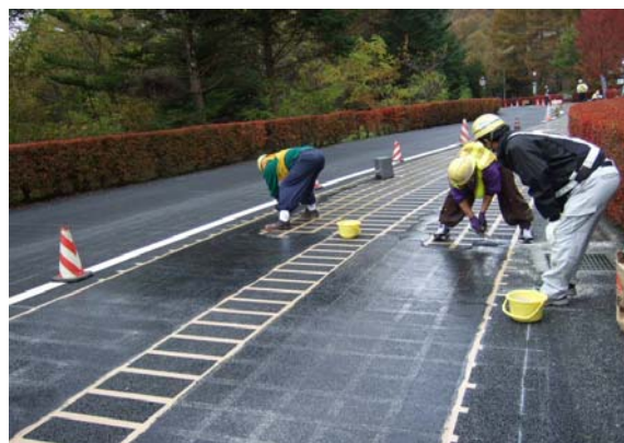
写真-6 充填材の注入状況
