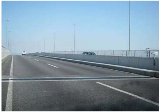
写真-6 針生高架橋伸縮装置部 (A1 橋台)
