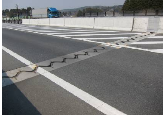
写真-12 日野渡橋伸縮装置部
