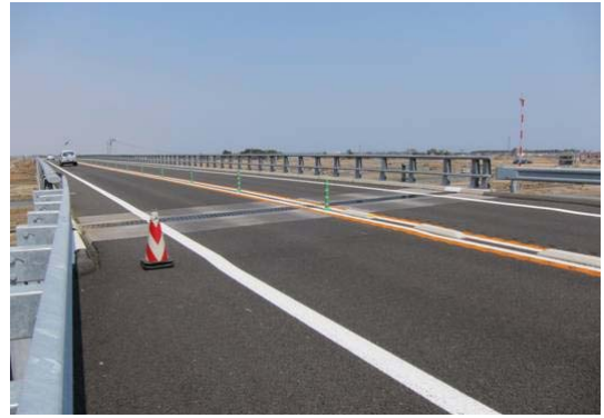
写真-9 鏡川橋伸縮装置部
