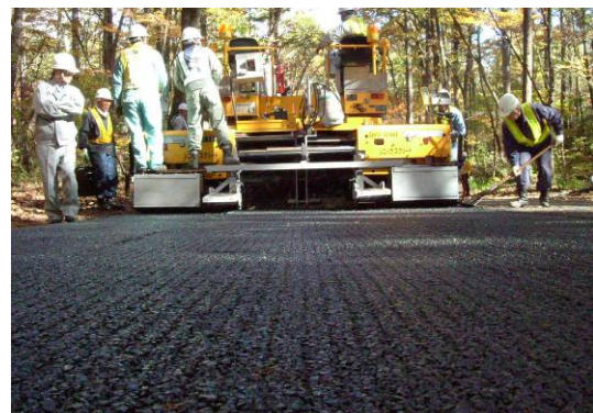
写真-1 FFP の施工状況
