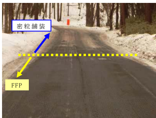
写真-3 施工ヤードの冬期路面状況
