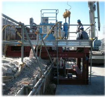
写真-7 施工確認試験状況
