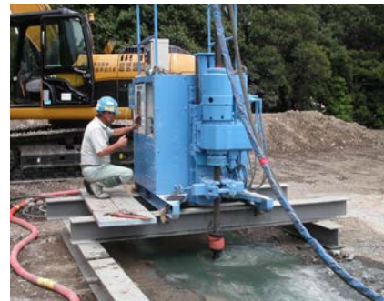
写真-3 切削試験状況
