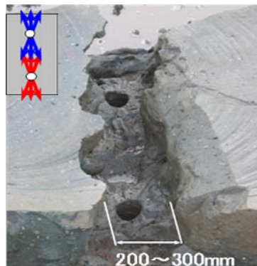
写真-5 切削スリット(放射)
