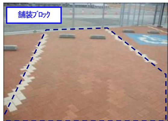
写真 4 CO<sub>2</sub>-SUICOM 適用状況
