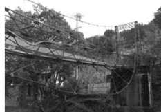
右岸下流側より撮影
