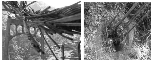
ケーブルが破断し、ばらけている状況を確認
