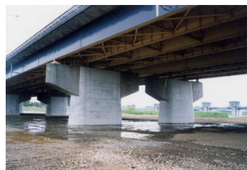
写真-7 AWS工法施工状況
