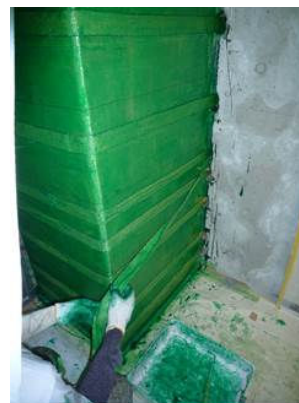
写真-6 帯シート貼付け状況
