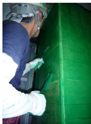
写真-5 カバーシート貼付け状況
