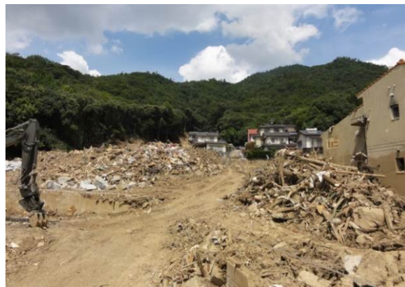
図-7.2 調査箇所①周辺写真（地上写真，八木3丁目）
