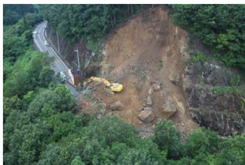
図-12.1 UAVにて撮影した崩壊法面【2015/7/23撮影】
