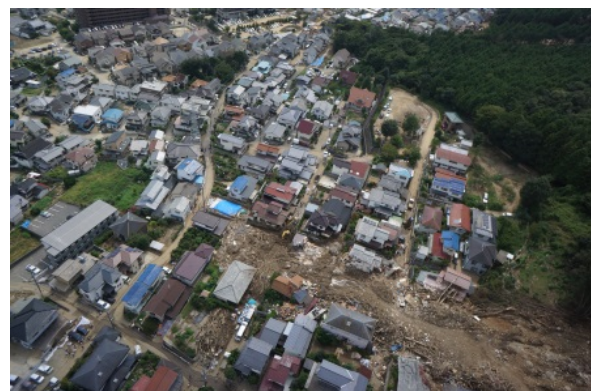
図-7.3 調査箇所②周辺写真（UAV斜め写真，八木4丁目）
