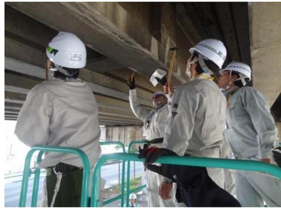
写真-3 打音点検体験状況(国道2号豊成高架橋)
