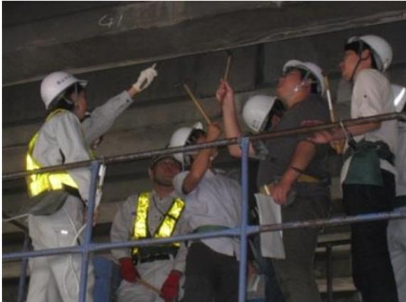
写真-5 打音点検体験状況（国道2号豊成高架橋）
