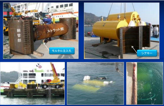
Re-Pier(伸縮式ストラット)工法
