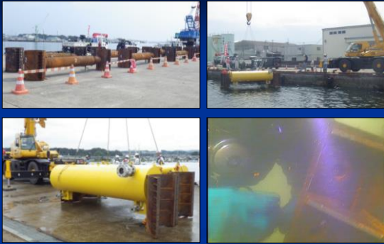
Re-Pier(伸縮式ストラット)工法
