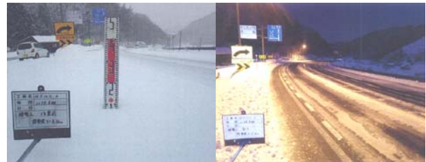
除雪工（作業前）
