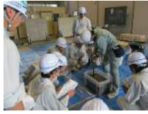
示方書遵守した施工方法(締固めの例)
