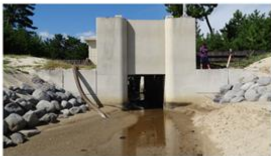
写真-2 鳶の子川排水樋門（正面）
