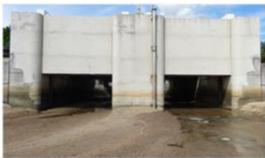
写真-1 枝虫川排水樋門（正面）
