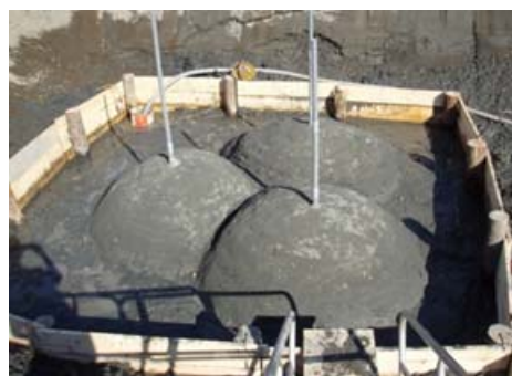
写真-1 発掘改良体[羽田空港実海域実験]
