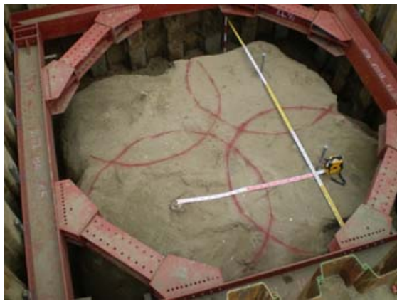
写真-5 改良体発掘全景
