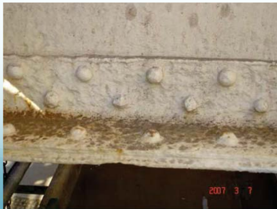
激しく腐食した床桁
