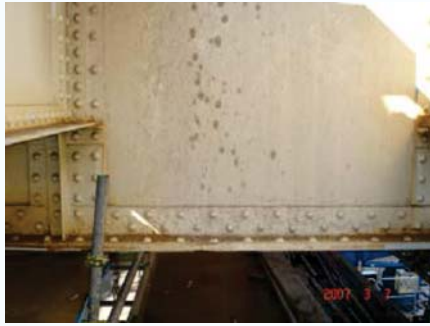
激しく腐食した床桁
