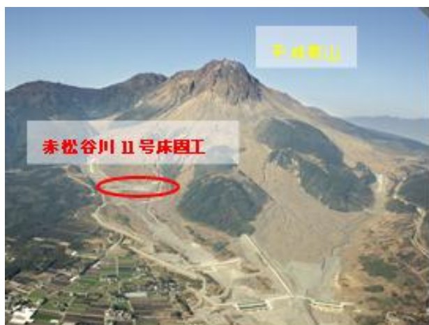
写真-1 工事位置
