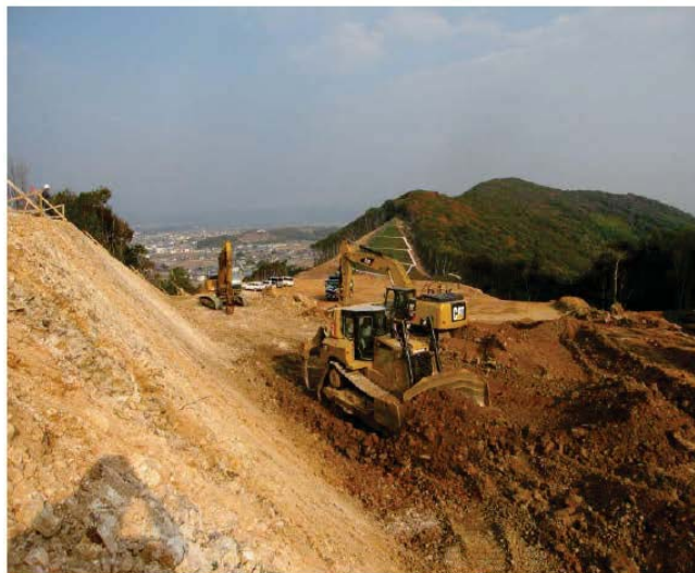
掘削(切土)施工中
