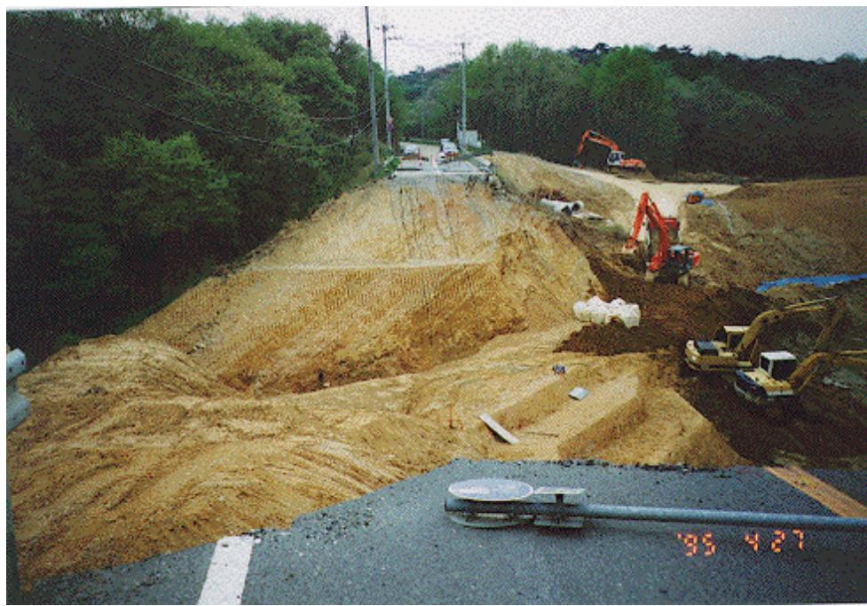
地震によるため池堤体の崩壊
