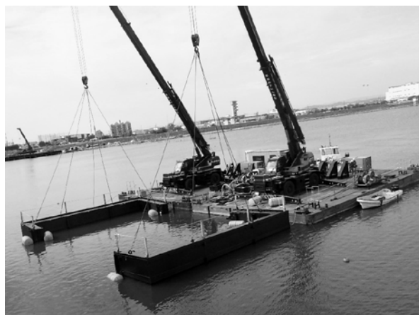
図-8 函体の曳航運搬
