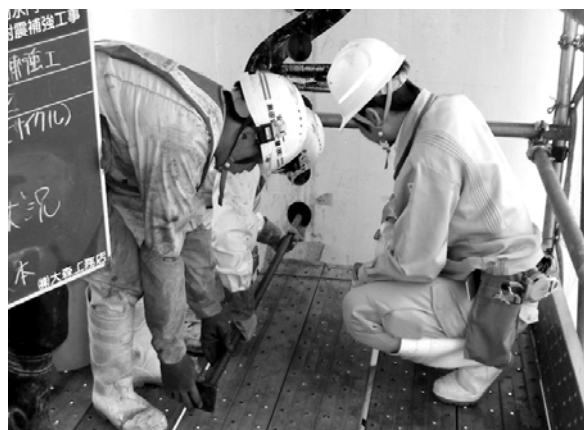
図-12 ポストヘッドバー挿入状況
