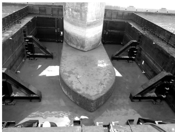
図-9 排水完了状況
