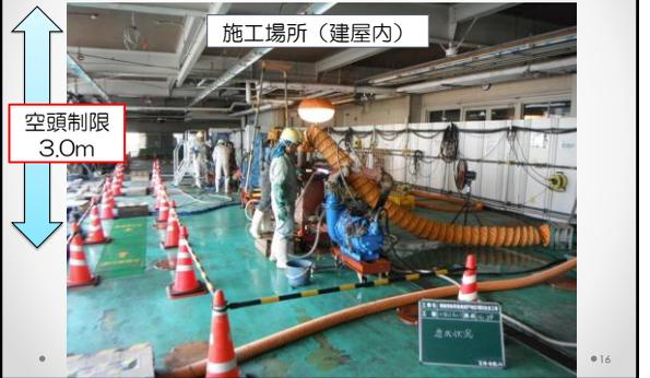
事例③-1 既設旧法タンク基礎補強工事 φ2.0m
