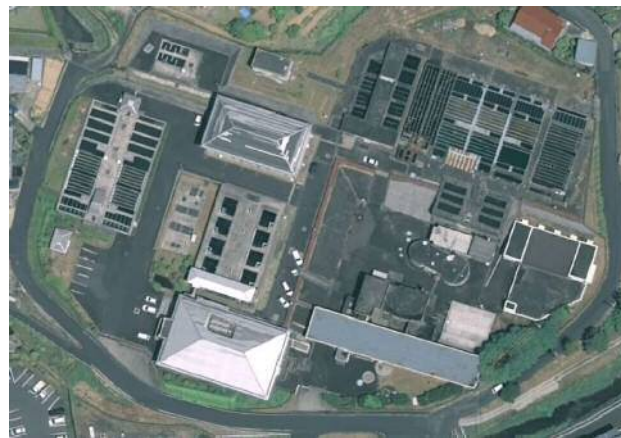
写真-1 更新前施設全景
