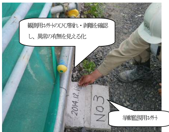
写真-2 A部変位動態観測「異常発生に見える化」
