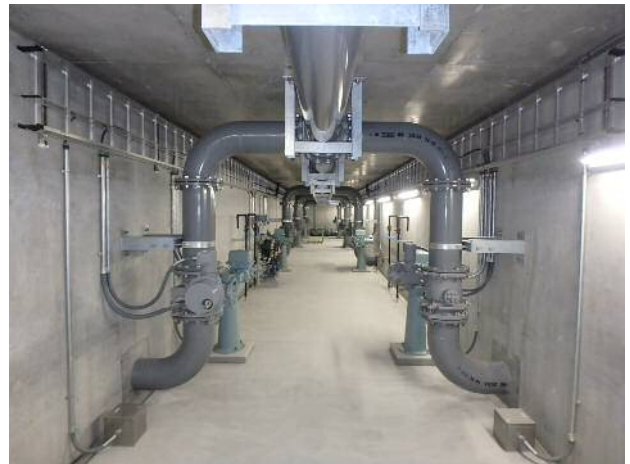
写真-7 急速ろ過池内部管廊
