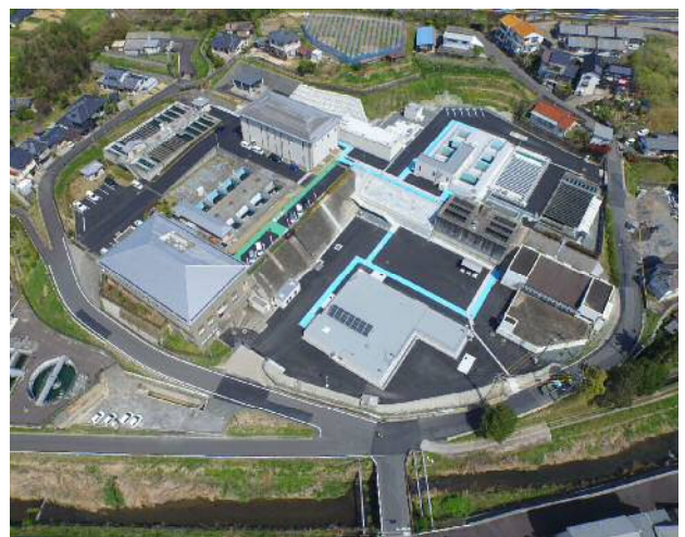
写真-8 完成後浄水場全景
