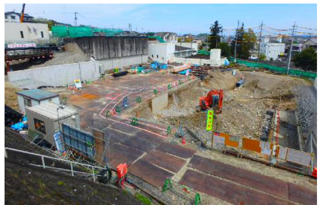
写真-4 踏み抜き防止 敷地内全面敷鉄板養生
