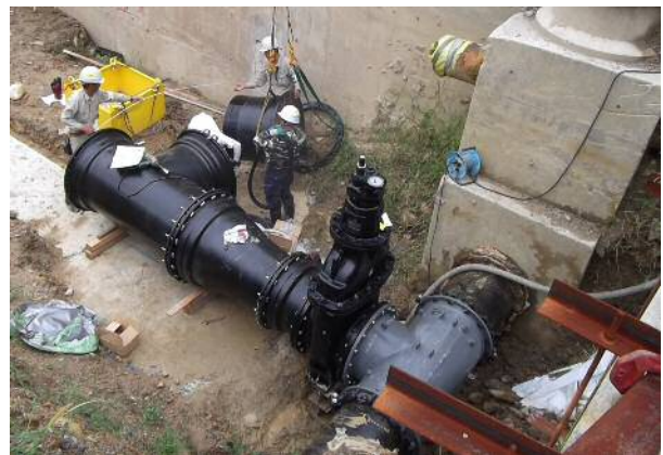
写真-3 場内配管工 不断水工法 (φ600)
