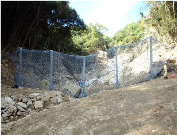
写真-8 強靱ワイヤーネット設置後の状況
