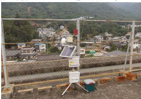
写真-4 設置したサイレンと回転灯
