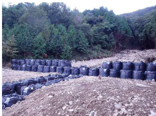
写真-5 大型土嚢を設置した溪流
