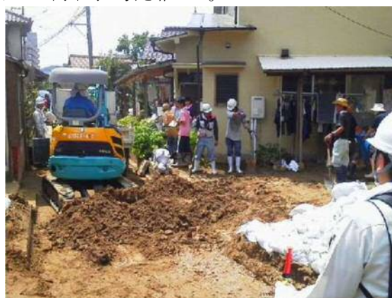
写真-6 地域やボランティアと協力し土砂を撤去
