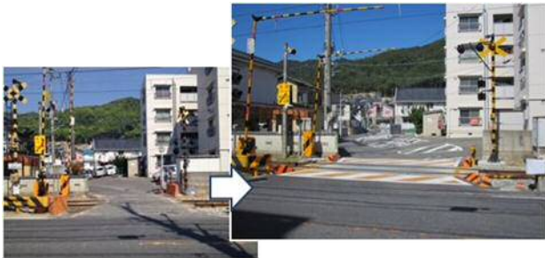
写真-9 市道や踏切の拡幅状況
