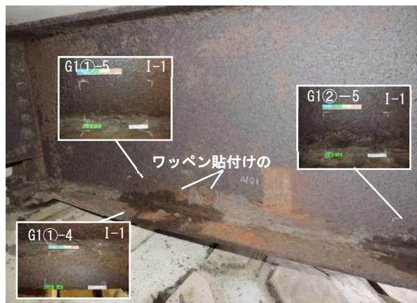
図-7 G1桁A1側内側のさび状態のI評点
