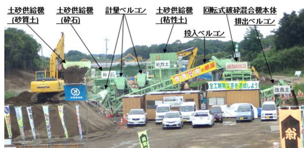
図-14 現場全景 (鬼怒川激特事業における施行事例)
