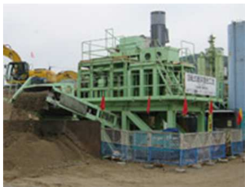
図-8 現場全景（軟岩破碎混合改良事例）
