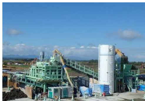
図-5 現場全景（高含水比粘性土改良事例）
