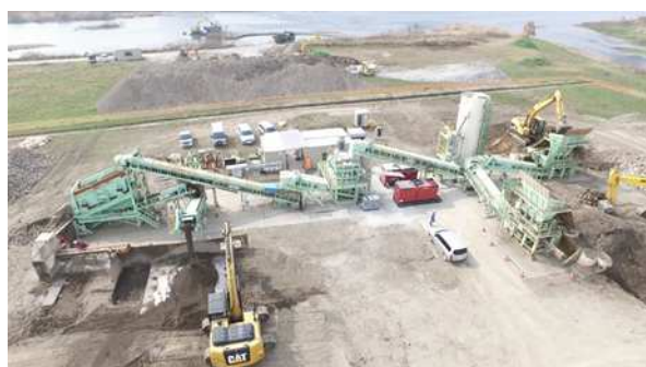
図-11 現場全景（草根ゴミ分別改良事例）
