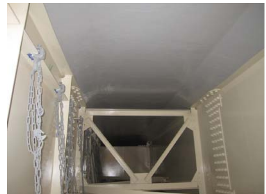
写真8 施工完了（床版下面）
