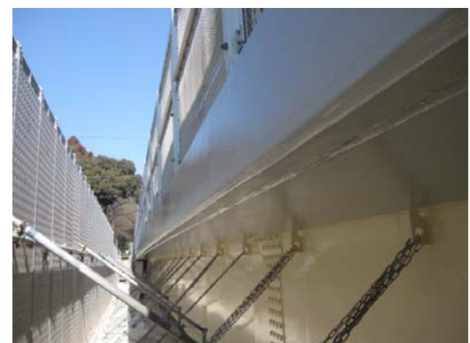
写真9 施工完了（張出床版下面，地覆側面）
