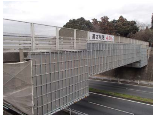
写真6 跨道橋補修工事の状況
