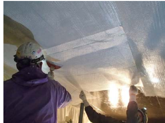
写真7 繊維シート貼付工
