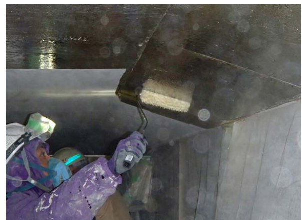
写真-2 プライマー塗布作業の状況
