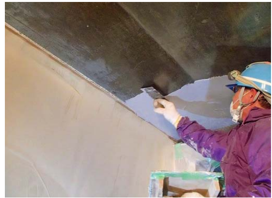
写真-3 接着剤の塗布作業の状況
