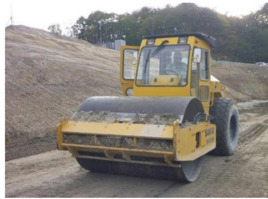
写真-5 振動ローラによる解砕土の締固め転圧状況
