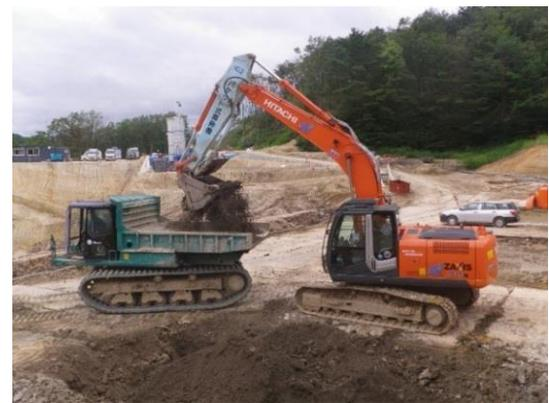
写真-3 バケット式解砕機による初期固化土の解砕状況
