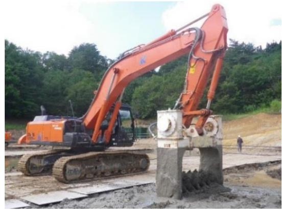
写真-2 DAM機によるピット内の混合泥土の初期固化状況
