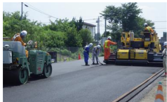
写真-3 試験施工状況
