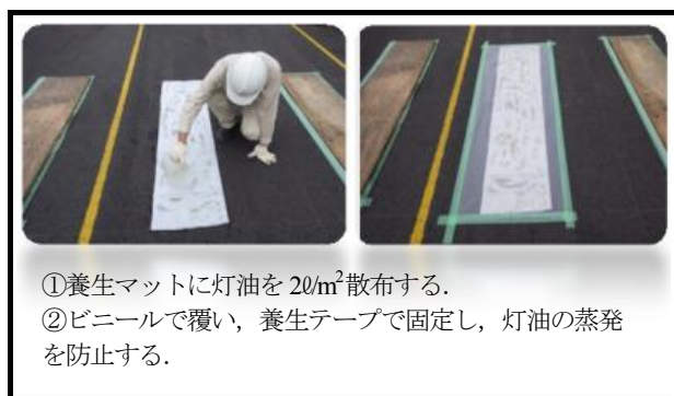
写真-4 油散布状況
