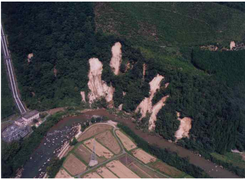
黒坂発電所下流の日野川左岸
