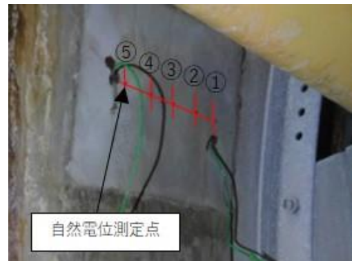
写真-4 自然電位測定点
