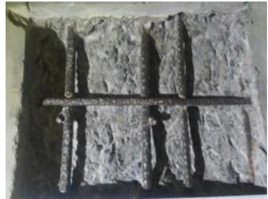
写真-2 コンクリートはつきり完了状況
