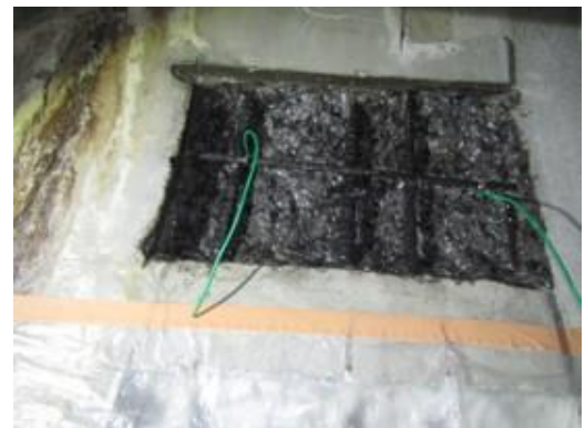
写真-3 HEPの塗布完了状況
