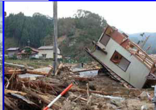
土砂流出による家屋倒壊 (豊岡市但東町奥赤)
