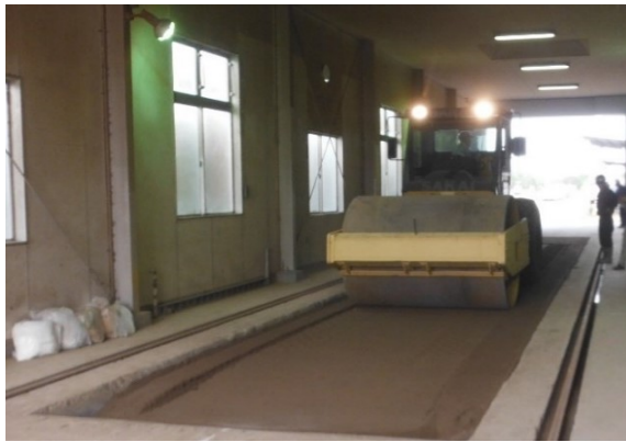
図-4 実大締固め試験状況
