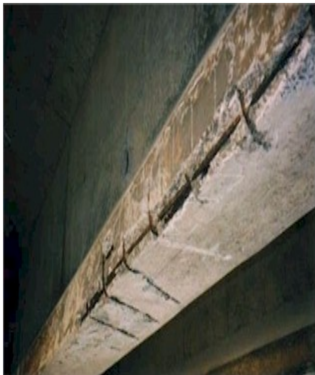
塩害による鉄筋腐食
