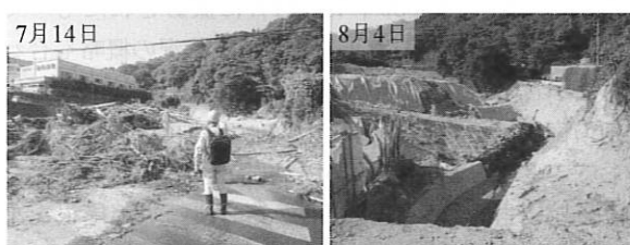
写真一2 昭和入口交差点から見た矢野川の土砂堆積状況
