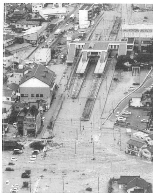
図一15 山陽本線瀬野駅における土砂の流入
