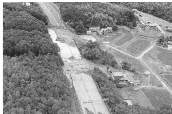
図三 山陽自動車道高屋 JCT-河内 IC間の土石流災害
