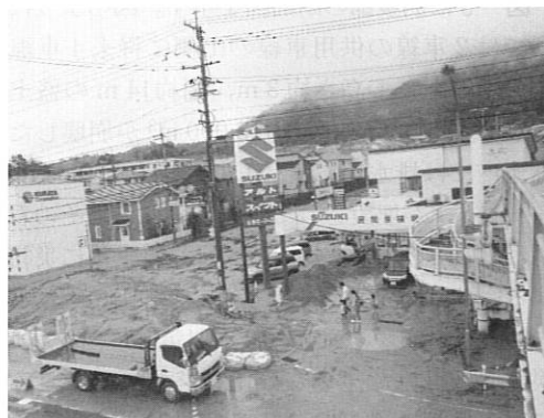
図一10 国道2号溝迫交差点付近の土石流の跡
