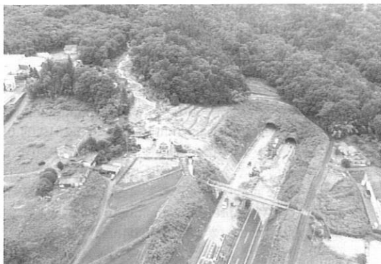
図一 山陽自動車道志和トンネルの東広島側入口付近で発生した土石流
