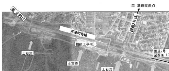
図一8 国道2号八本松付近における土石流災害
