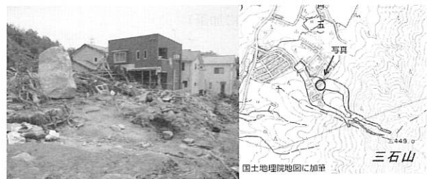
写真一3 巨石の被害を受けた住宅
