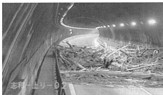
図二 山陽自動車道志和トンネル内を移動する土砂と流木でできた「天然ダム」
