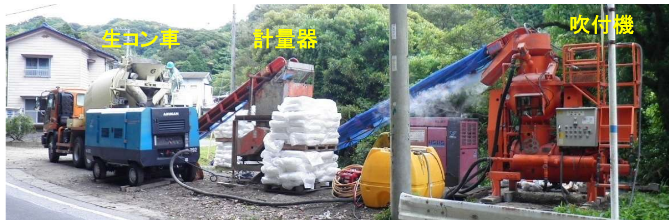
生コン車によるモルタル供給時のプラント
