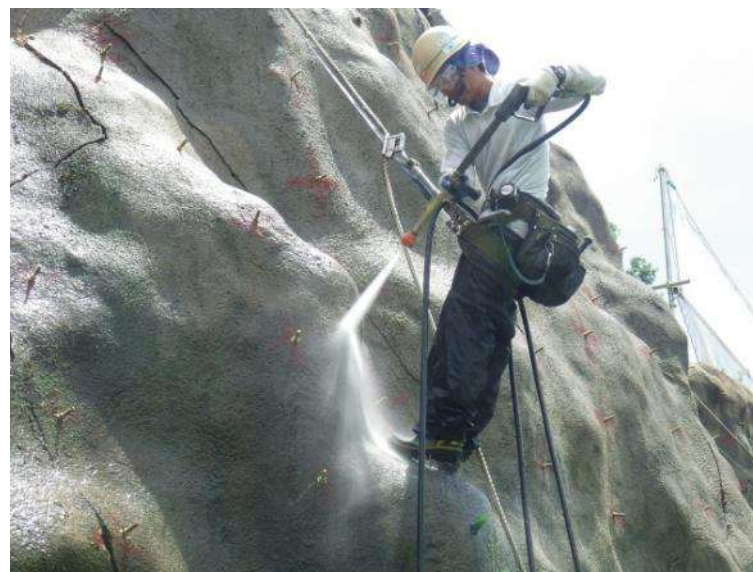
④水抜きパイプ新設 (既設吹付に削孔し、新たに設置)
