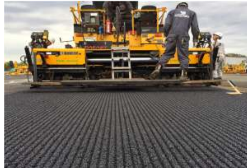
シニックスクリード(国際特許申請中)による敷均し状況
