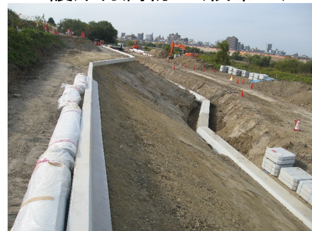
基礎工(護岸) (プレキャスト)
