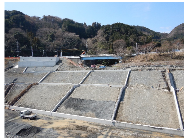
護岸付属物工(横帯工)
