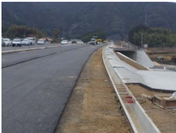
側溝工(U型側溝)
