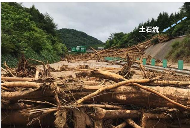
図-3 山陽道土石流被害 高屋 JCT 西側
