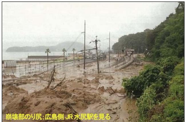
図-10 広島呉道路 盛土のり面崩壊跡 のり尻部
