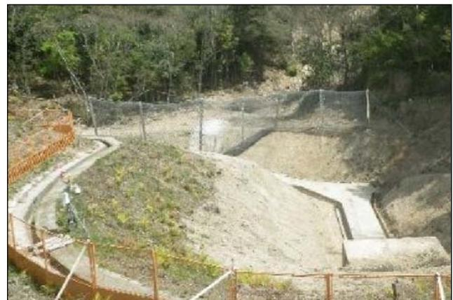
図-20 自衛対策工…高エネルギー吸収型防護工 (2)
