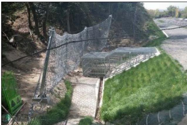
図-19 自衛対策工…高エネルギー吸収型防護工 (1)
