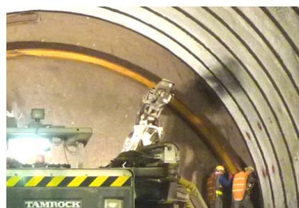
写真-3 鋼製支保工の建込み
