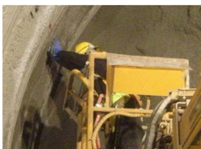
写真-2 ロックボルトの挿入状況
