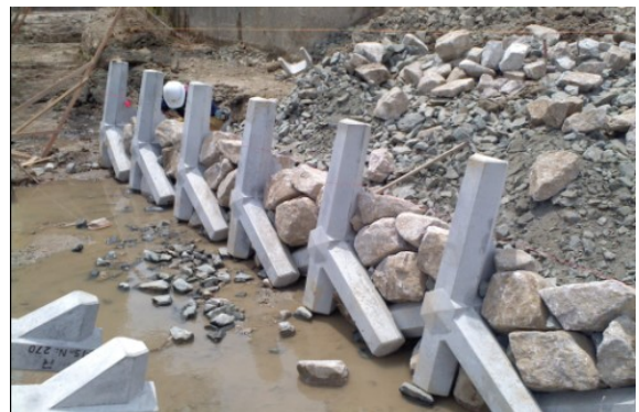
写真-3 1段目～前石設置状況
