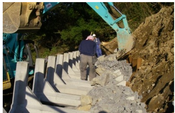
写真-4 中詰材・裏込材施工状況
