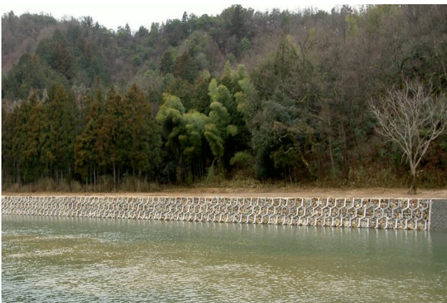
写真-20 NETIS 試行施工完成写真
