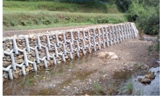
写真-6 河川護岸の施工例
