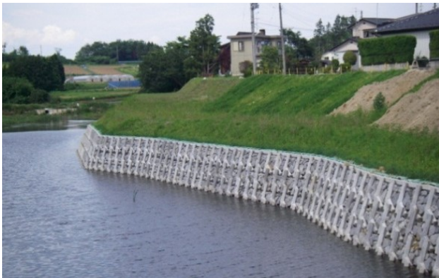
写真-12 法面改修完成写真
