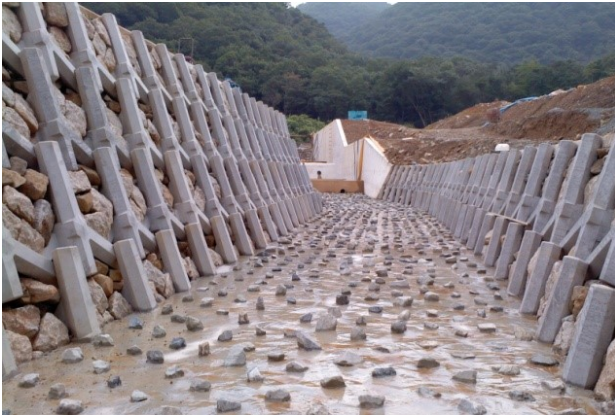
写真-18 河川護岸完成写真①
