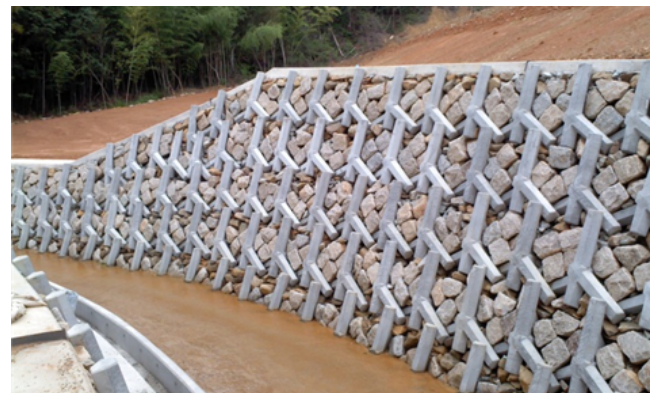
写真-10 河川右岸擁壁施工例
