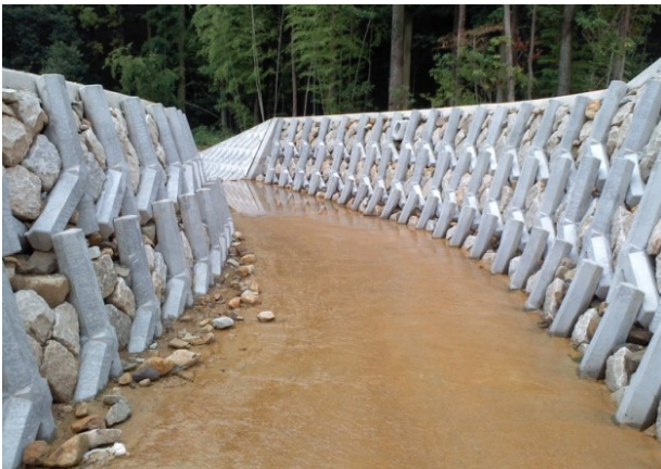
写真-19 河川護岸完成写真②
