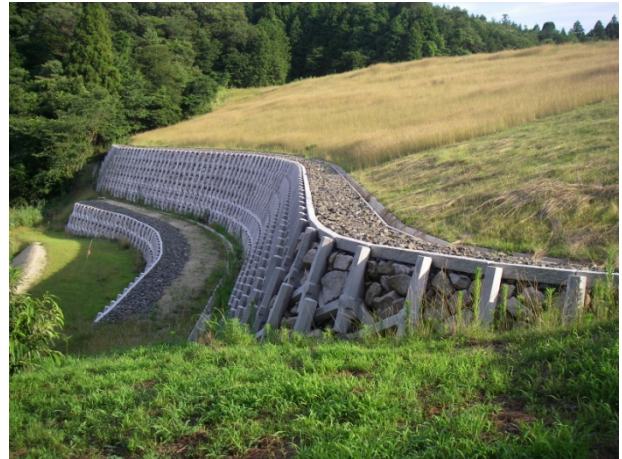
写真-14 完成全景（2段擁壁+盛土）
