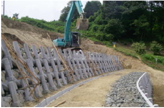
写真-5 ブランチブロック設置状況
