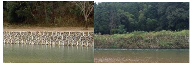
写真-7 植生緑化の施工事例 (右写真：5年後)
