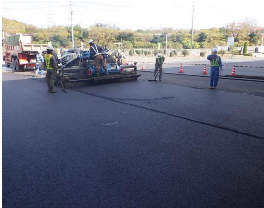
写真-9 スーパーポリアスコンの施工状況
