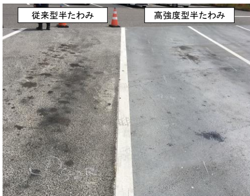
写真-10 ウルトラペーブ H の供用状況 (供用 1 年)
