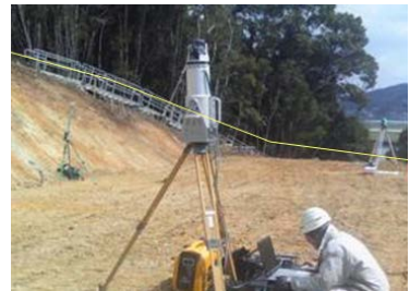
短時間で施工箇所の3次元測量を実施
