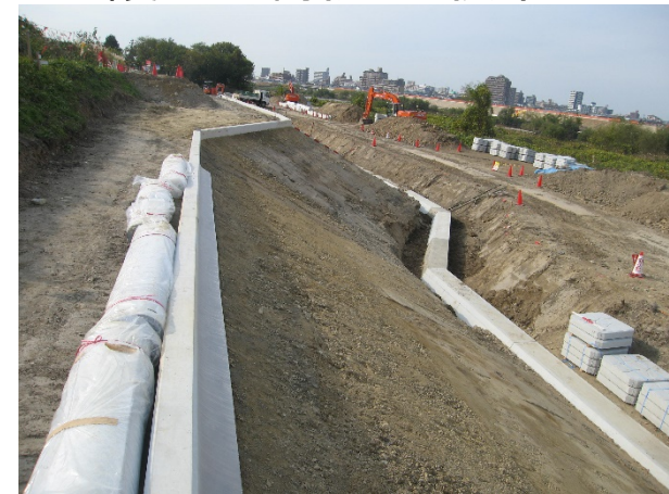
基礎工（護岸） （プレキャスト）
