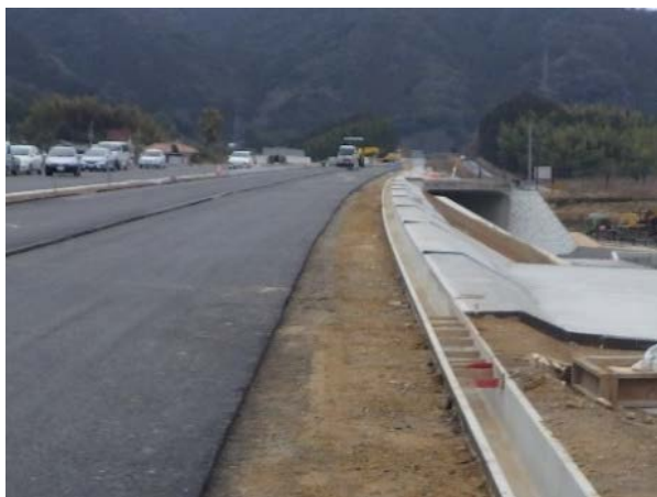
側溝工（U型側溝）
