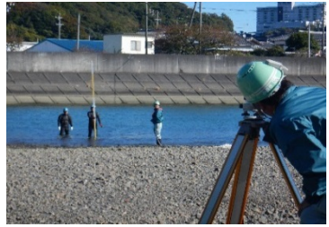
土工と同様の起工測量
