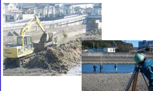
施工と検測を繰り返して整形
