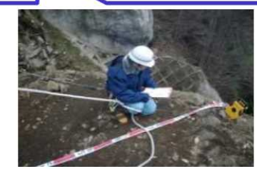
高所斜面上の臨場検査
