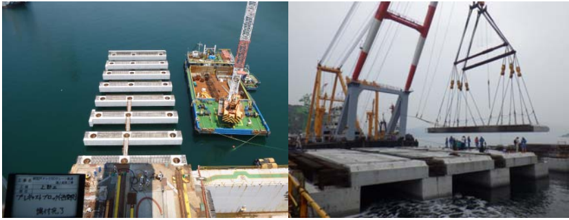
写真-5 プレキャスト部材の架設
