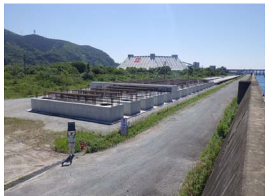
写真-4 プレキャスト部材の全景
