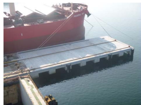
写真-7 完成（西軌道）
